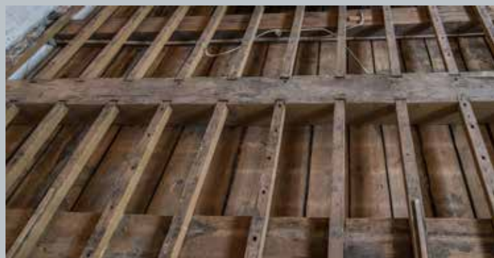
Bovenkant van het moer en kinderbinten plafond uit 1545. In de 18de eeuw werd deze vloer boven de rechter kamer versterkt met tussenliggende lagere balken. Deze balken en de planken daar onder dragen het onderliggende stuc plafond. In de kinderbalken zitten gaten voor het aandrijven van de vloer (foto: team Erfgoed Zwolle)
