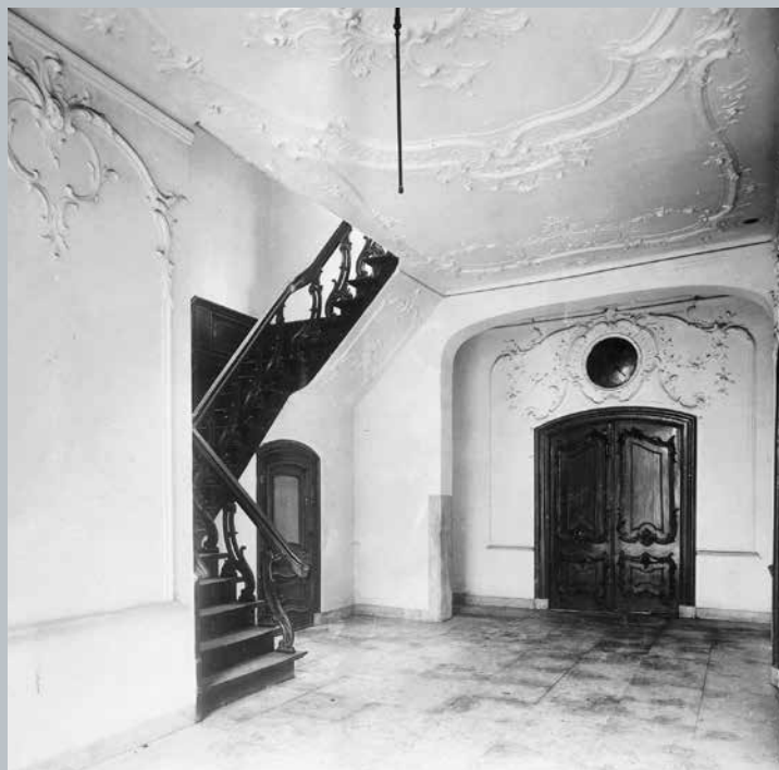
De hal van het gesloopte huis Middelwijk aan de Nieuwe Markt (RCE beeldbank: 063011).
