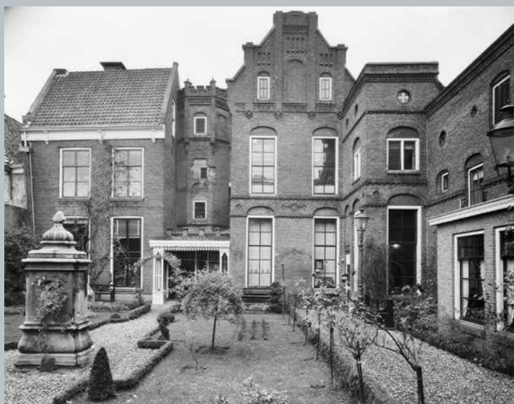
De neogotische achtergevel van huis Helmich. Naast het huis aan de linkerkant lagen bijgebouwen die zich uitstrekten tot de Voorstraat. Naast de traptoren aan de linkerkant is de niet verbouwde achtergevel uit de 18de eeuw (RCE beeldbank: 059901).
