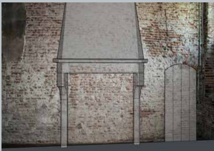
Bouwsporen in de wand vertellen iets over de indeling van de ruimte omstreeks 1545. De ingetekende haard en deur geven hier globale indruk van (afbeelding: team Erfgoed Zwolle).
